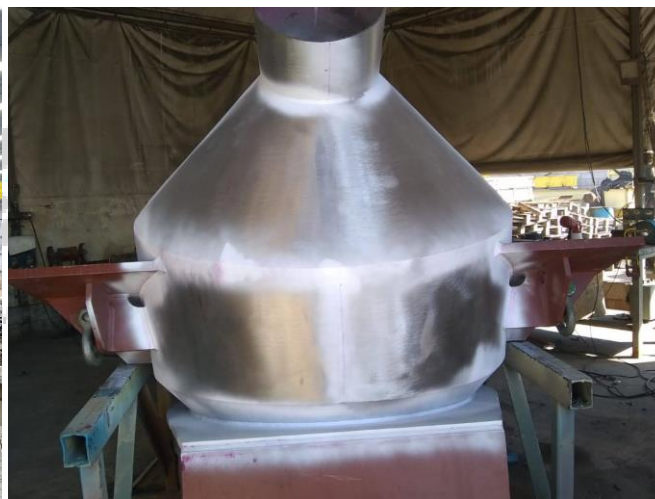
RESERVATÓRIO DURANTE ENSAIO DE LÍQUIDO PENETRANTE
